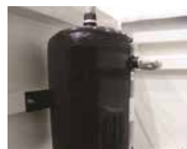
Наличие ресивера гарантирует надежность смены инструмента
